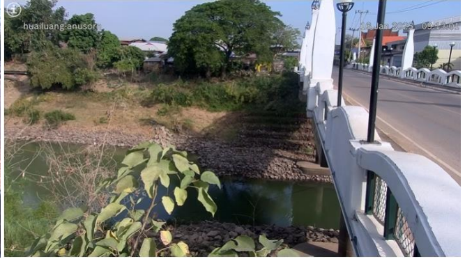
C031703 : สะพานห้วยหลวงอนุสรณ์ ต.จุมพล อ.โพธิ์ชัย จ.หนองคาย
